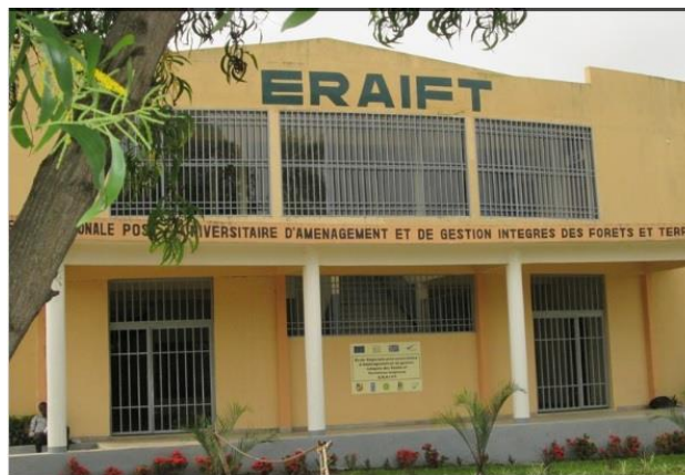
Principal bâtiment administratif de l'ERAIFT
